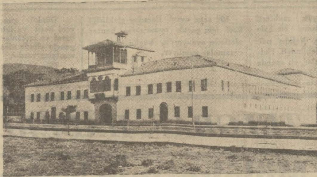
Malatya ortamektebi binası
